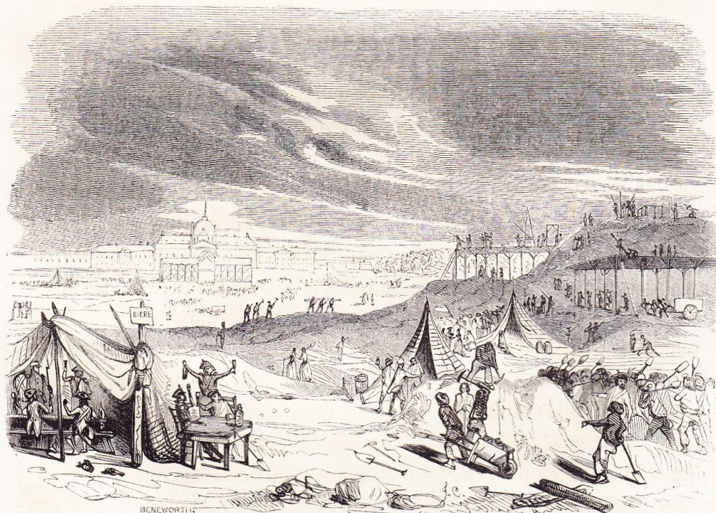
Travaux exécutés au Champ de Mars.
